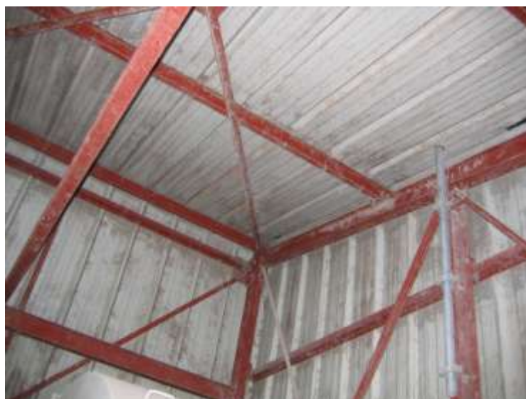
Figure 11 : Bardage simple peau
