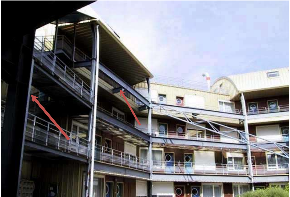
Figure 2 : Structure métallique avec structure porteuse apparente (exposée) ©Archiguide Guide Architecture
