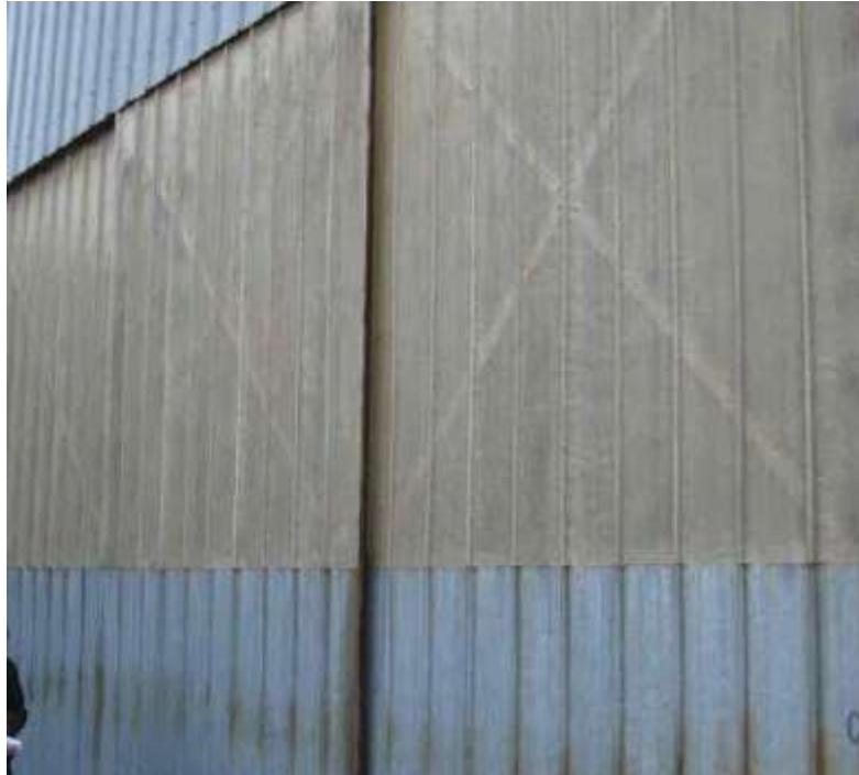
Figure 12 : Exemple de façade translucide
