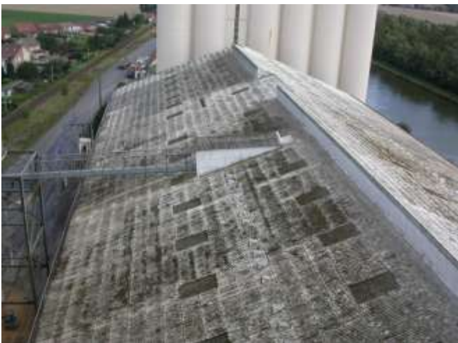
Figure 13 : Couverture en fibrociment
